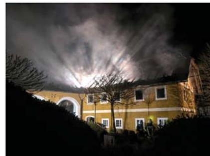
Im Anschluss wurde der Dachboden abgeräumt, da hier Stroh als Dämmung verwendet wurde, das sich durch den permanenten Wind immer wieder entzündete.
